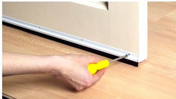
Abbildung 7-12: Zugluftstopper zur Verminderung des Luftaustausches bei geschlossener Tür
