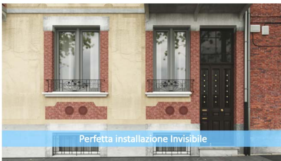
Abbildung 7-16: Optisch gelungene Ausführung der Kernbohrungen für das Wandgerät ‚Zymbo Silent‘ der Fa. Zymbo Italia Slg. Mit freundlicher Genehmigung.
