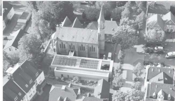
Das Luftbild zeigt gut die neue PV-Anlage auf dem Dach des Neheimer Gemeindehauses.
